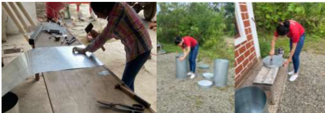
Figura 7. Construcción y adecuación de 3 silos metálicos
