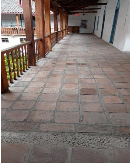
Figura 12. Pasillo de la segunda planta
