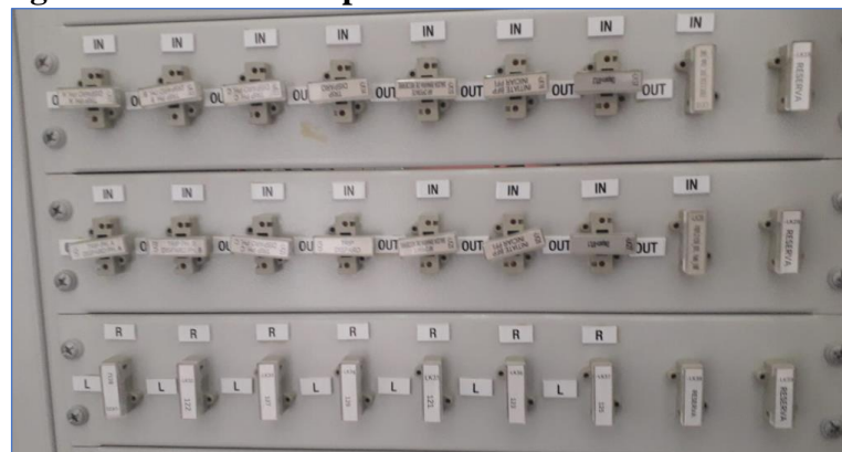
Figura 56. Posición de puentes de aislamiento IE1 e IED2
