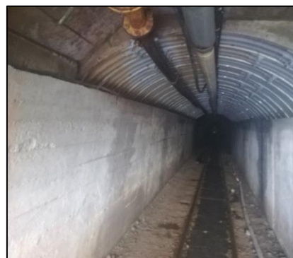
Figura 30: Fortificación de hormigón en la boca mina
