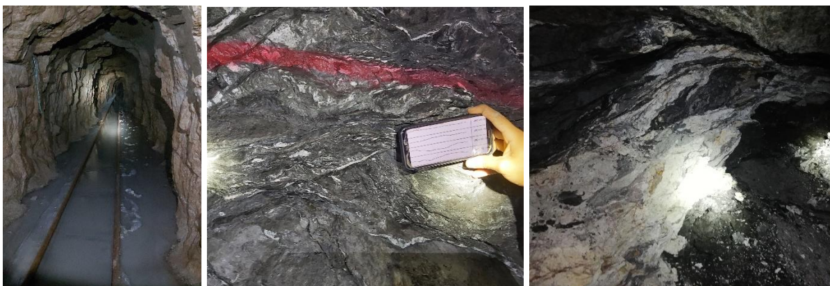
Figura 39: Galería abandonada inundada y stockwork de cuarzo Ubicación: a 267.5m del pozo en el 3er nivel (galería abandonada) Fecha: 05/2021 Fuente: El autor
