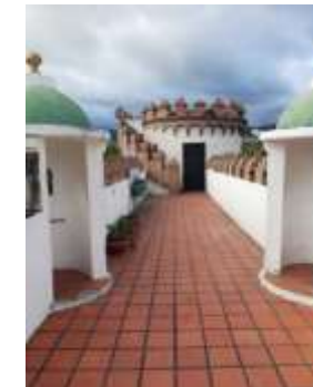
Figura 23. Pasillos dentro de las torres de la Puerta de la Ciudad
