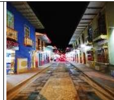
Figura 26. Casas patrimoniales Calle Lourdes
