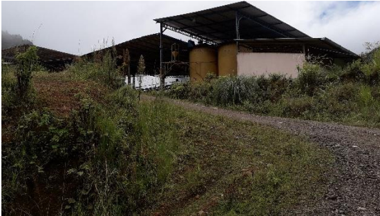
Entrada al área Minera "Cambanas"
