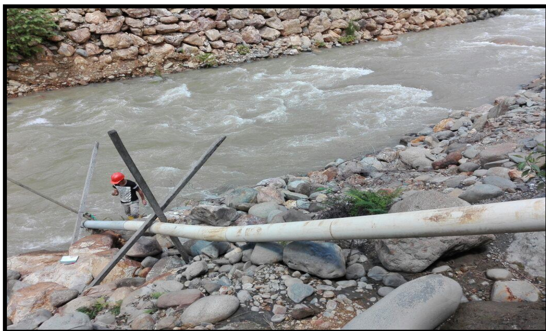
Fotografía 4. Punto de Descarga hacia el Rio Calera
