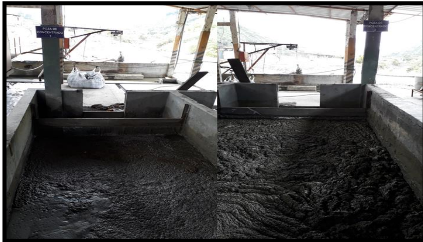
Fotografía 26. Tanques o Pozas de escurrimiento del concentrado
