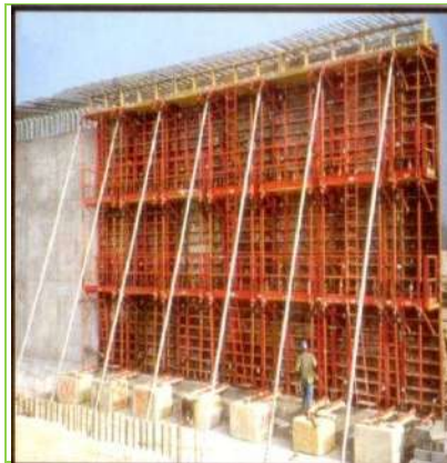
ENCOFRADOS PARA MUROS
