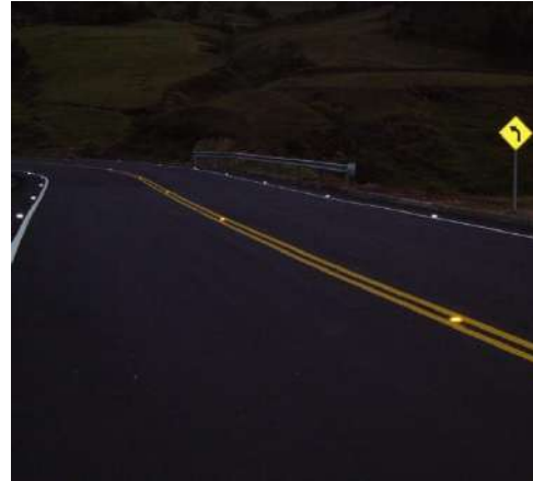
SEÑALIZACIÓN DE LAS VÍAS
