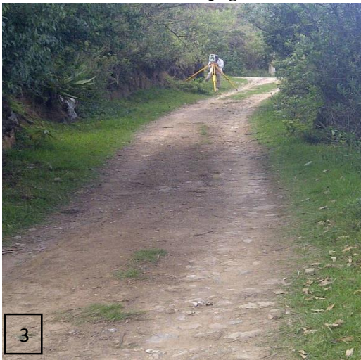
Foto3. Levantamiento topográfico de la vía
