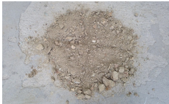
Figura 40. Cuarteado del suelo
