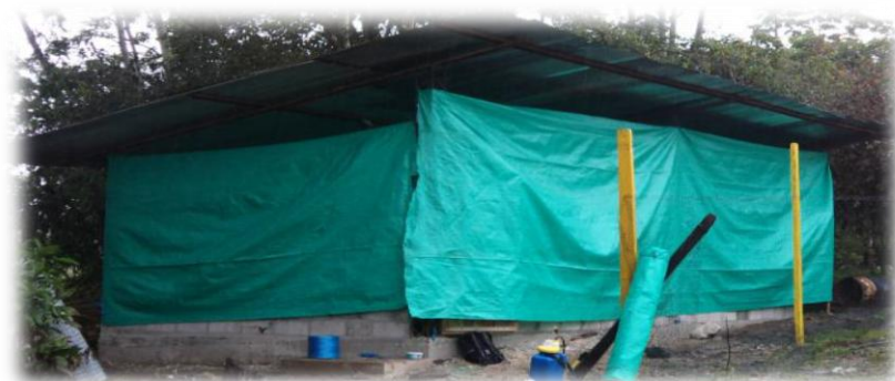
Fotografía 1. Infraestructura del galpón.
