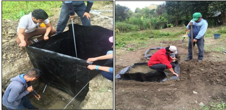
Figura 6. Colocación de la camisa de plástico y colocación de las capas de suelo.
