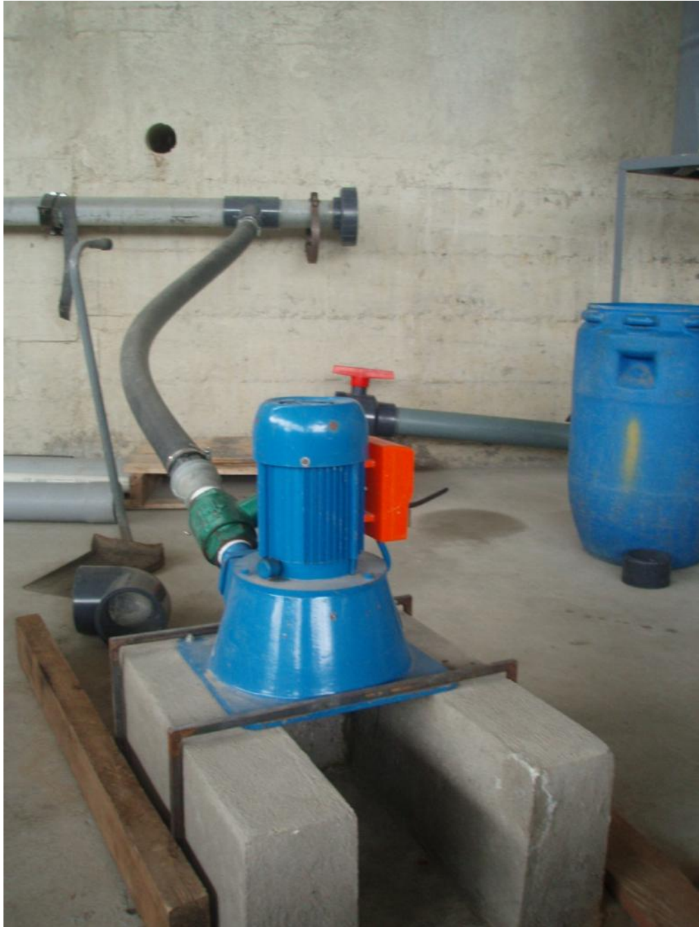
Fig. 21: Instalación de la turbina Turgo.
