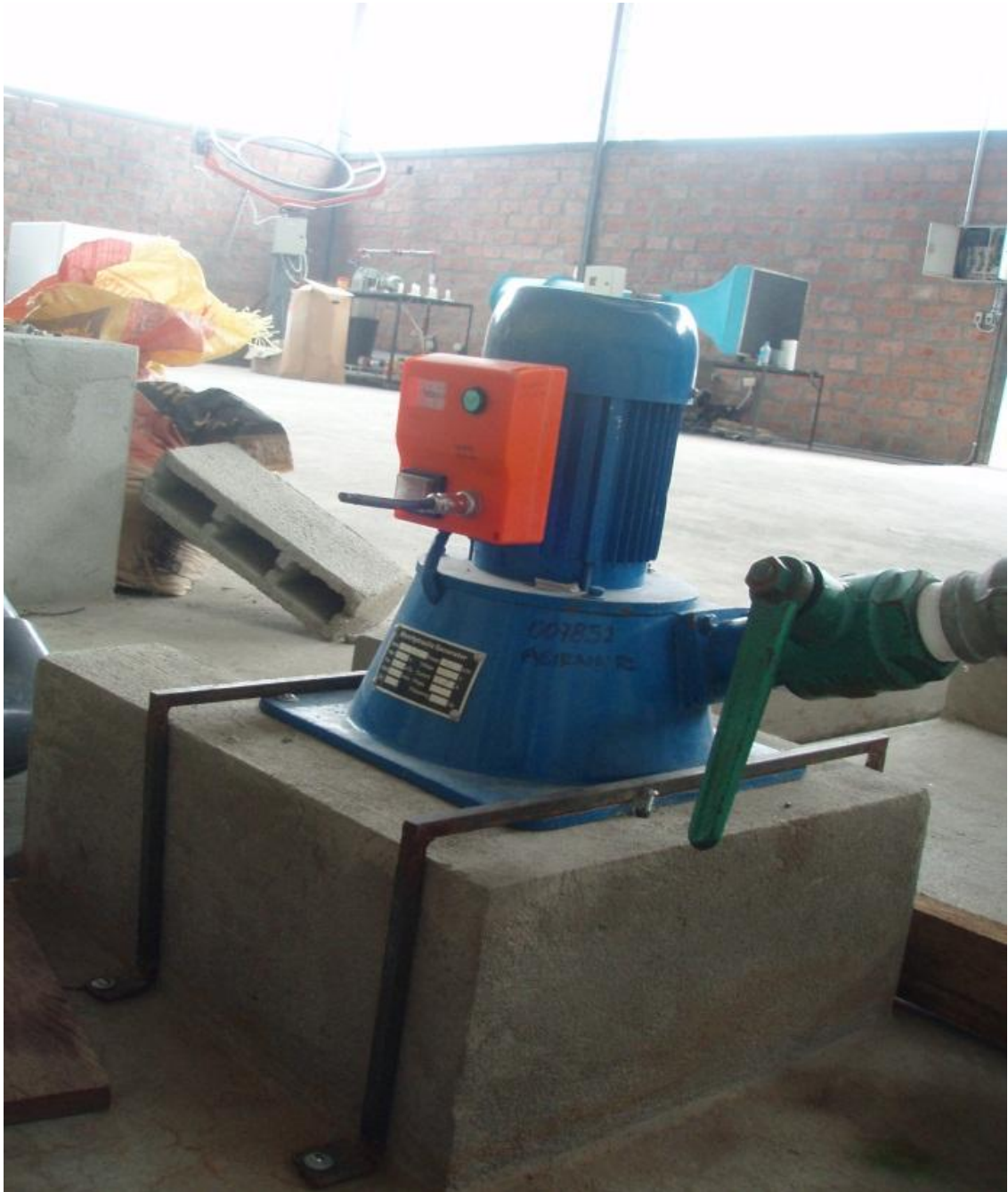
Fig. 18: Base para anclar la Turbina.
