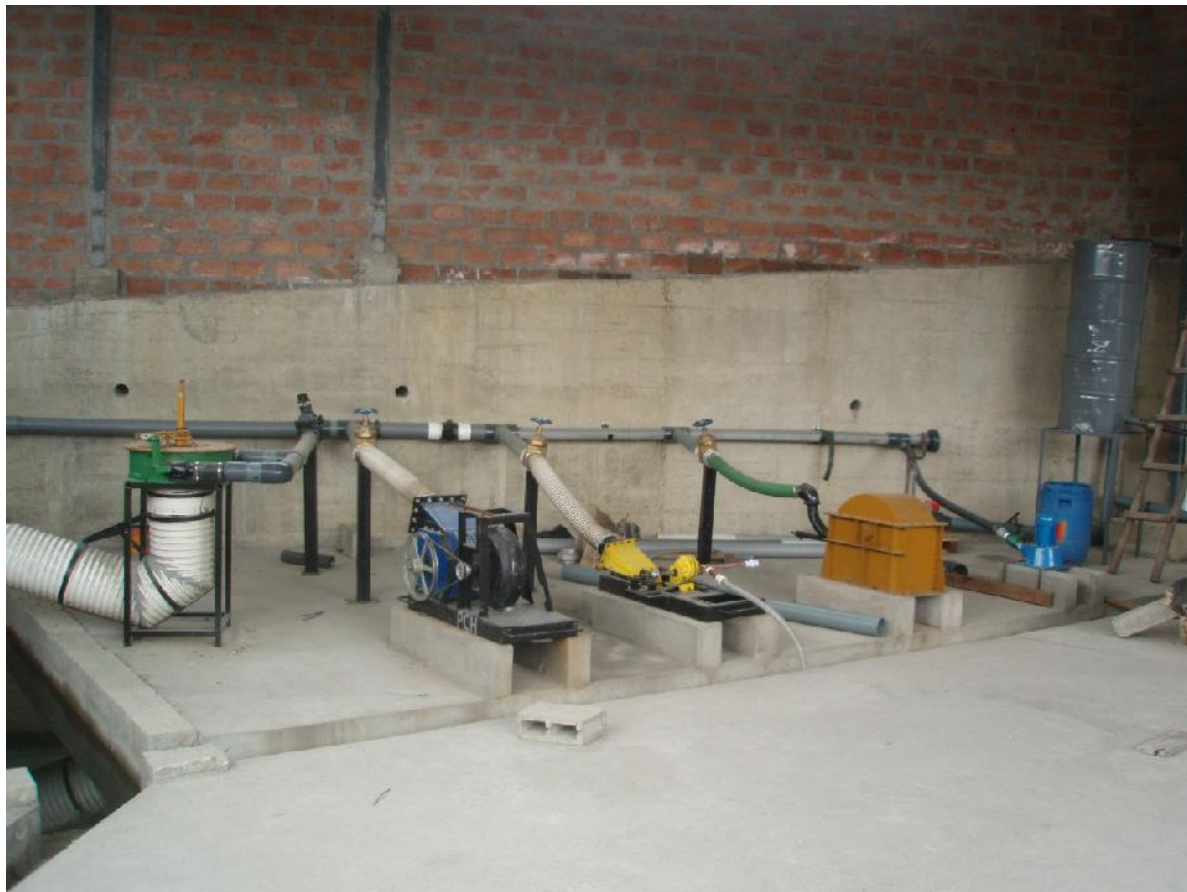
Fig. 20: Instalación de las tuberías de PVC.
