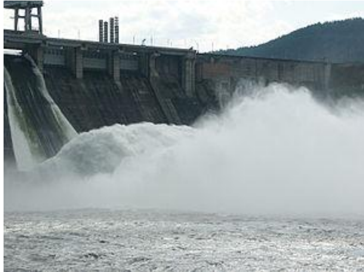
Figura 9: Central Hidroeléctrica. Fuente: Sitio Web 8.
