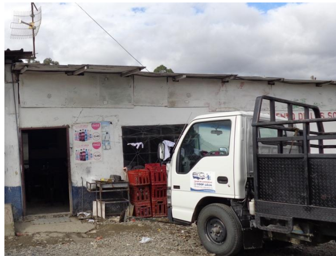
Fig. 27 Vivienda del encargado de cuidar los talleres
