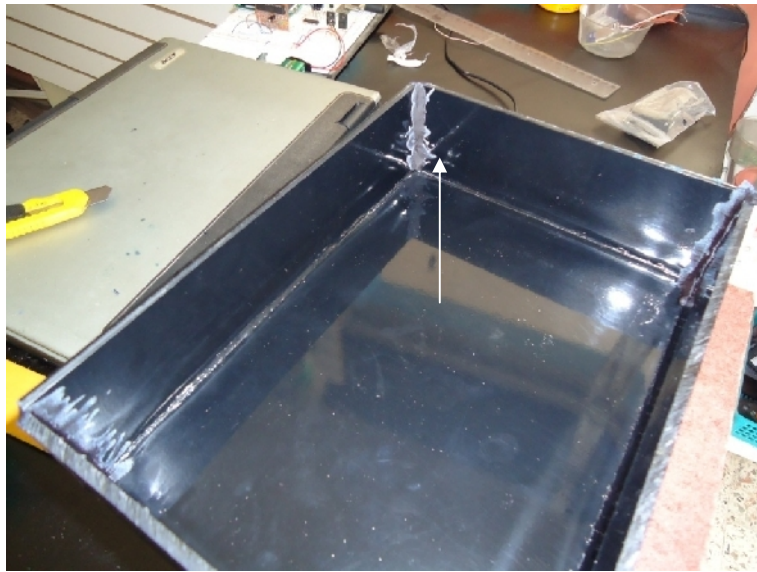
ANEXO Nro.-43 Esquinas selladas con acrílico líquido.
