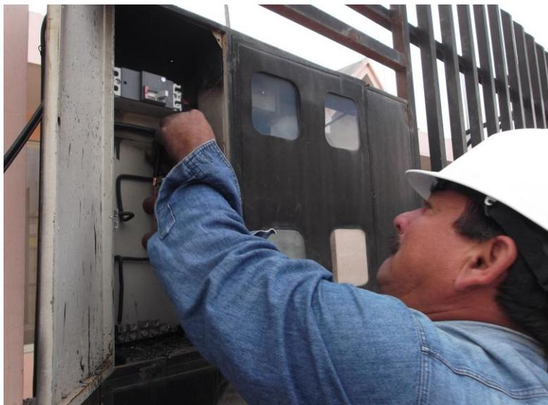
**Figura 18:** Fijación del breaker.
