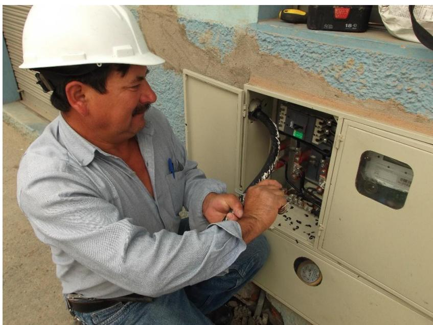
**Figura 19:** Alimentación del breaker principal.
