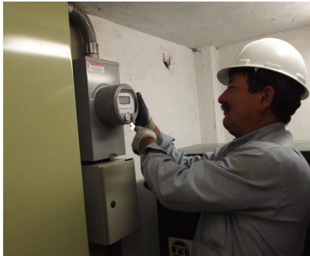
**Figura 26:** Colocación de sellos de máxima seguridad.
