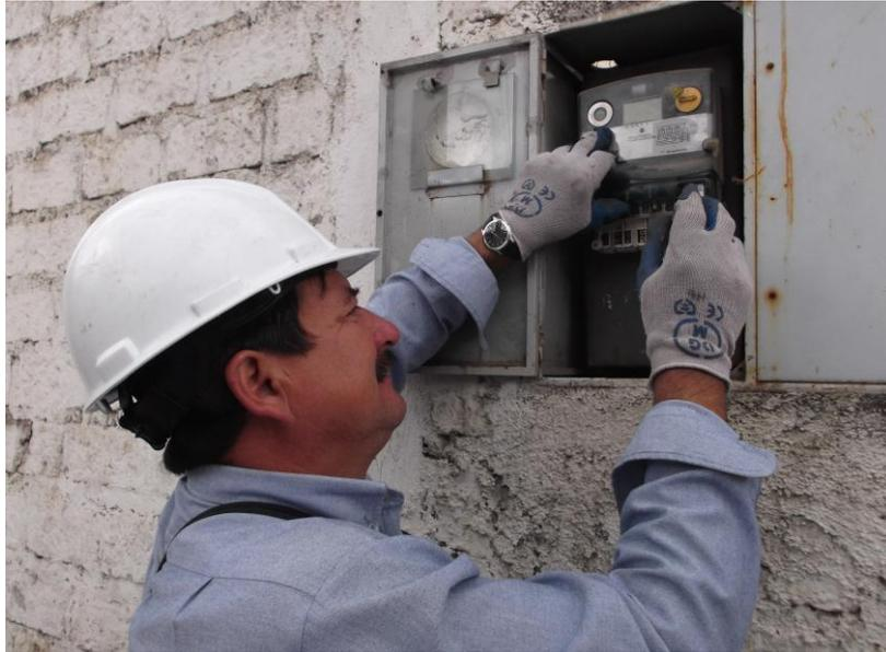
**Figura 17:** Fijación de medidor al tablero.
