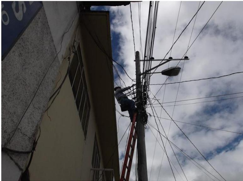
**Figura 24:** Conexión de la acometida a la red de distribución.
