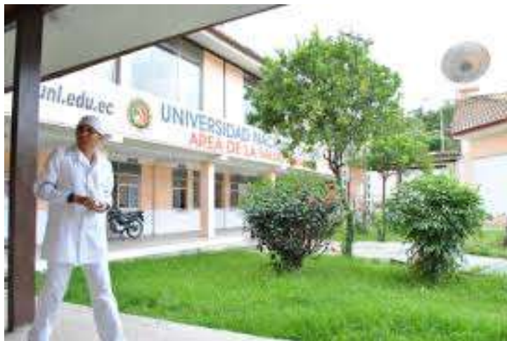
Figura 3: Área de la Salud Humana Fuente: Instalaciones de la UNL
