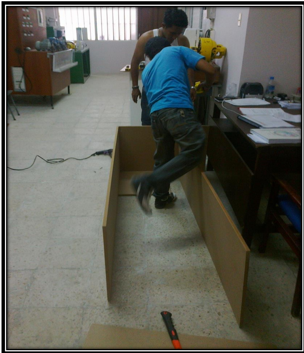
Figura 17. Construcción del tablero de control.
