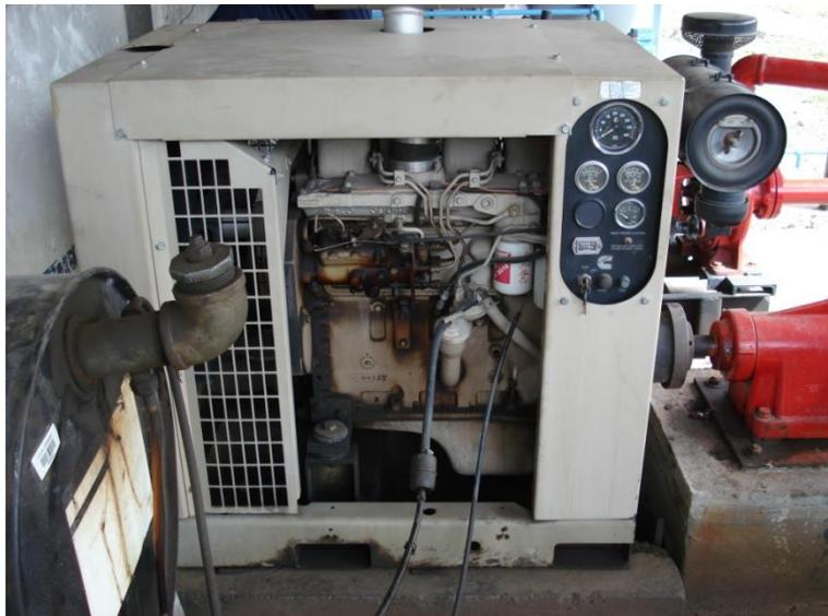
Fig. Anexo V.13. Motor Cummins Bomba de Agua
