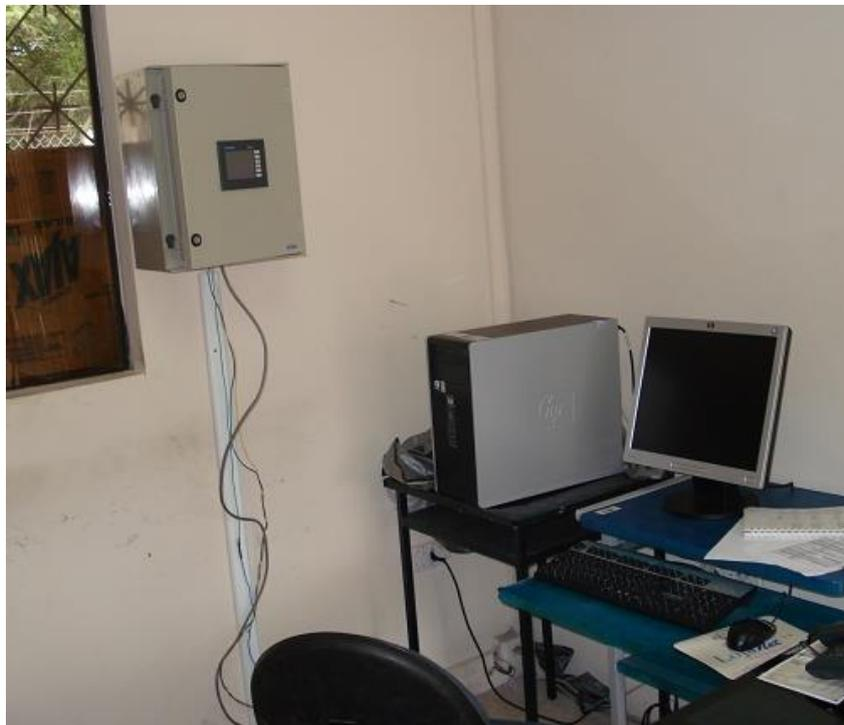
Fig. Anexo V.19. Instalación del Terminal de Operador
