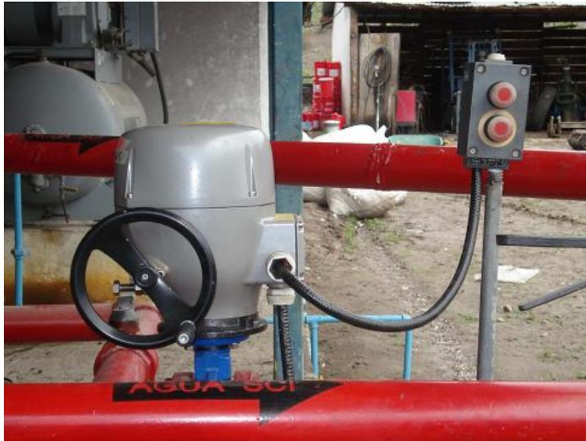
Fig. Anexo V.16. Botonera para el Control Manual del Actuador
