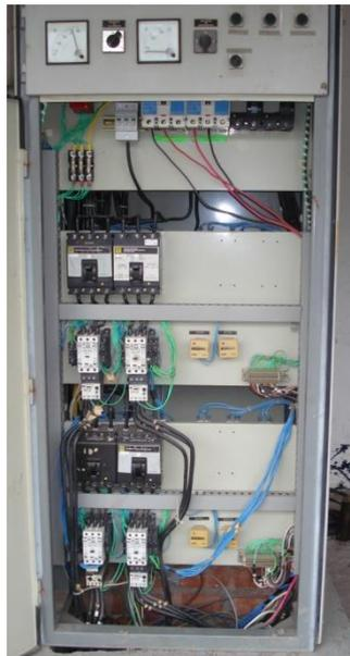
Fig. 2.6. Tablero de Fuerza de Bombas y Compresores de GLP
