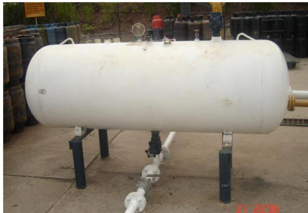
Fig. 2.8. Tanque de Almacenamiento de Gas de Cilindros con Fuga
