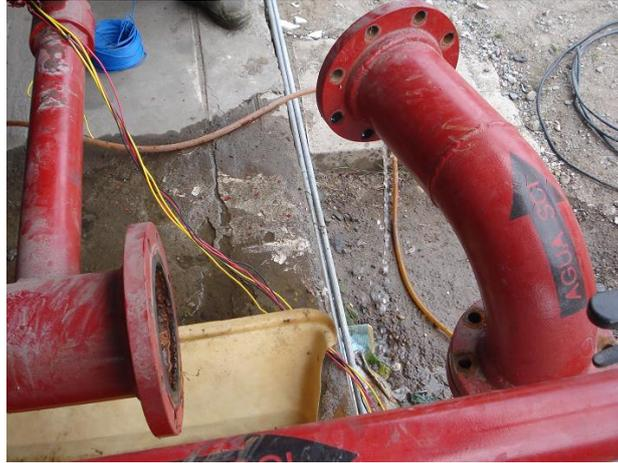
Fig. Anexo V.14. Tubería Principal de Alimentación de Agua
