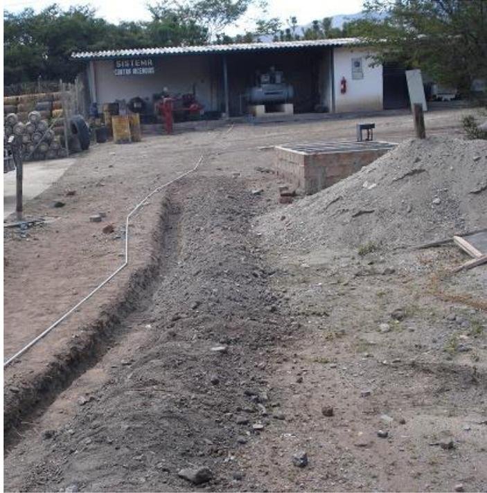
Fig. Anexo V.18. Tendido de Tubería
