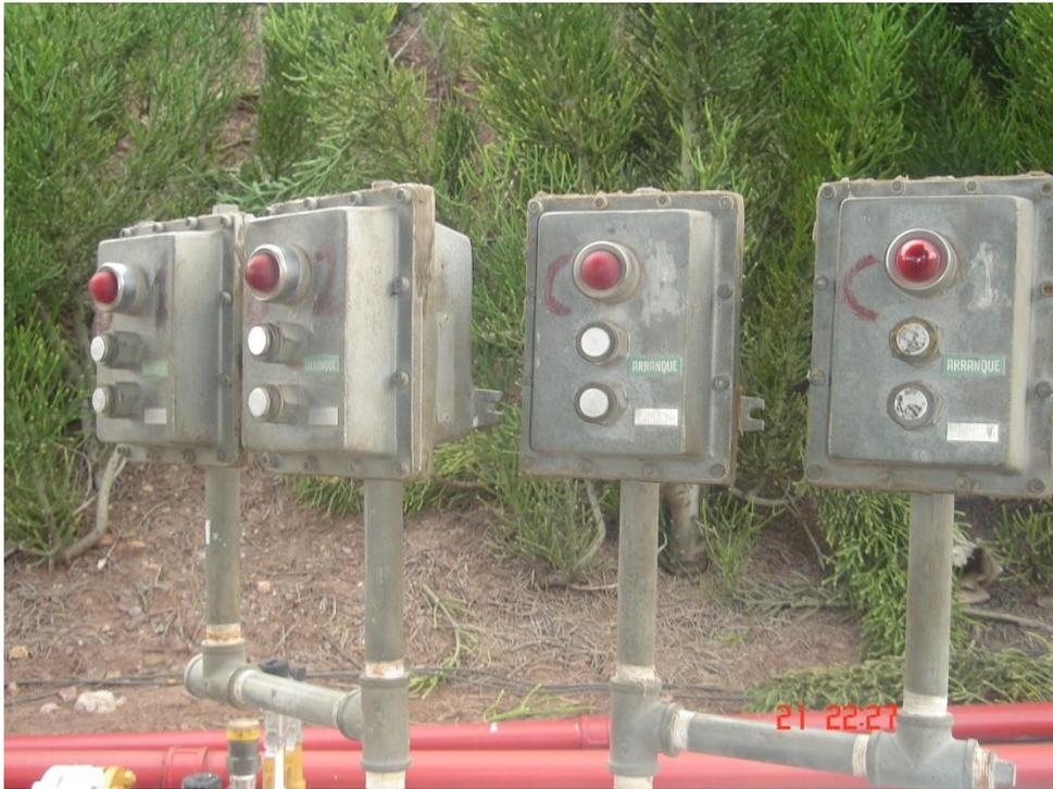
Fig. Anexo V.22. Botoneras de Encendido y Apagado de Bombas y Compresores
