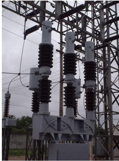
Figura 3.4 Disyuntor de pequeño volumen de aceite
