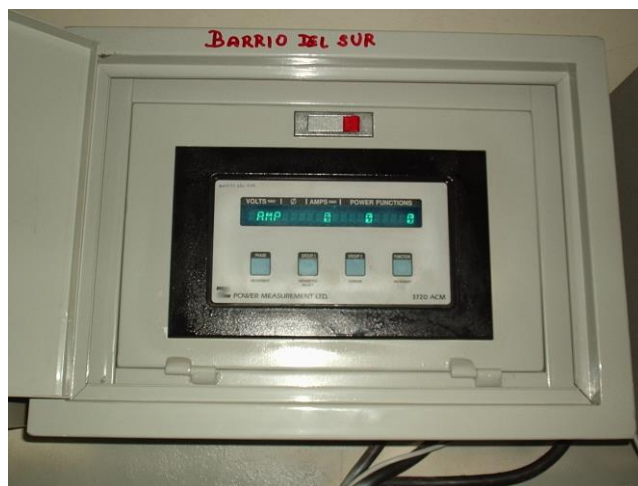
Figura 3.10 Medidor Trifásico de Energía 3720 ACM
