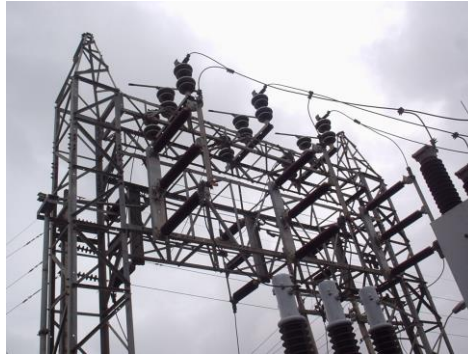
Figura 3.5 Cuchillas de bypass tripolares
