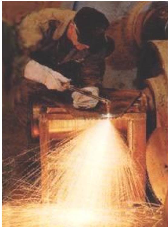
Fig. 9 Máquina soldadora, corte con gas
