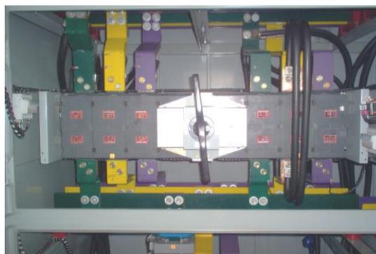
Figura 3. Conmutación para la Energía Eléctrica de la EERSSA o del Turbogenerador WEG.
