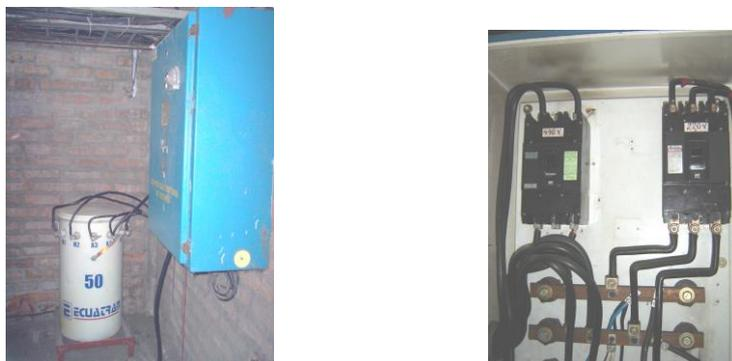
Figura 2.22 (a) Transformador de 50 kVA. (b) 3 Barras de Cu de 1" de altura, 1/4" de espesor, 17" de longitud pertenecientes al transformador de 50 kVA.
