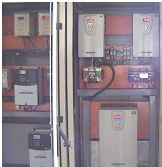
**Figura 6. Variadores de frecuencia del Centro de Carga Meladura.**
