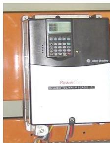
Figura 3.3 Variador de Frecuencia PowerFlex 70
