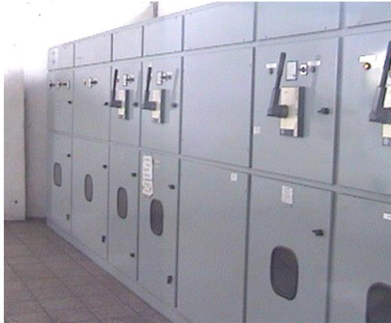
**Figura 4. Control de mando de los Centros de Cargas del Ingenio Monterrey MALCA.**
