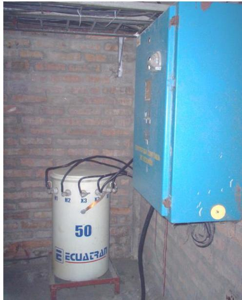
Figura 8. Transformador de 50 kVA.
