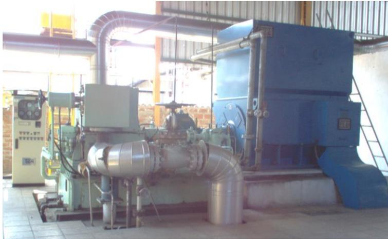
Figura 1. NUEVO TURBOGENERADOR MARCA WEG
