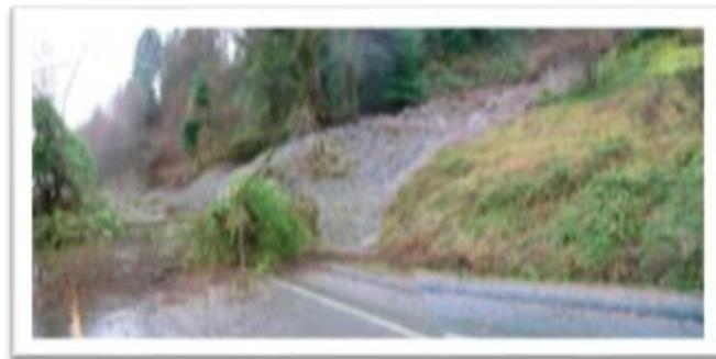
**Fotografía 2.14.** Deslizamiento por Flujo.
