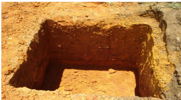
Fotografía Nº 11; Calicata Construida en el sector céntrico del área de estudio.
