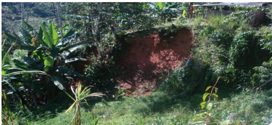
Fotografía Nº 14; Deslizamiento de Tierra se localiza al sur-este del área de estudio
