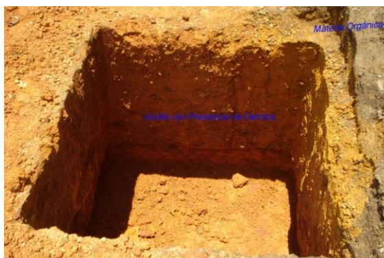
Fotografía N° 2; Calicata Construida en Terreno Arcilloso, en la zona céntrica del área de estudio.
