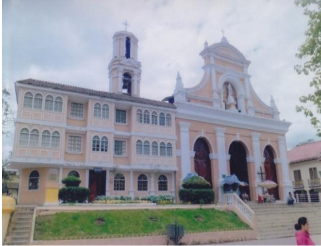
Fotografía, vista frontal
