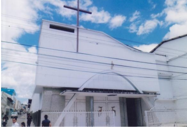
Fotografía, vista frontal
