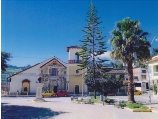
Fotografía, vista frontal
