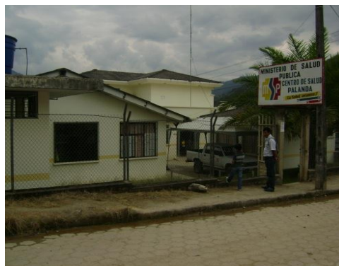
Figura N°11: Foto del Hospital
