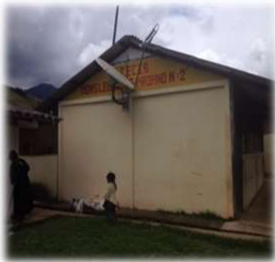
Figura 15c. Instalaciones de la Escuela Monseñor Leonidas Proaño 2 Fuente: Escuela Monseñor Leonidas Proaño 2
