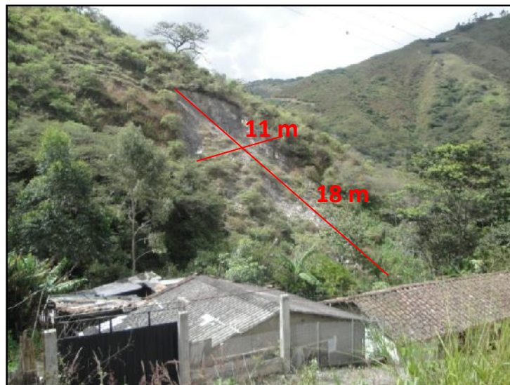
Fotografía 14. Caída de rocas, ubicado al Noreste del barrio Sacapo.
