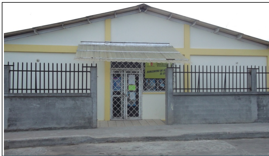
Figura 30. Sub-Centro de Salud de la Parroquia
