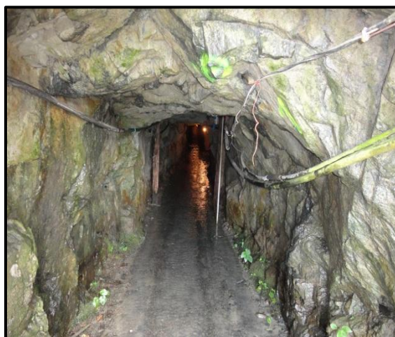
Foto N° 19: Bocamina El Valle
