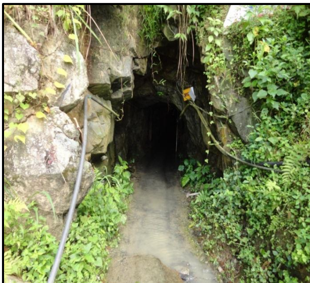
Foto N ° 10: Entrada a la galería principal de la Labor Minera El Valle.
