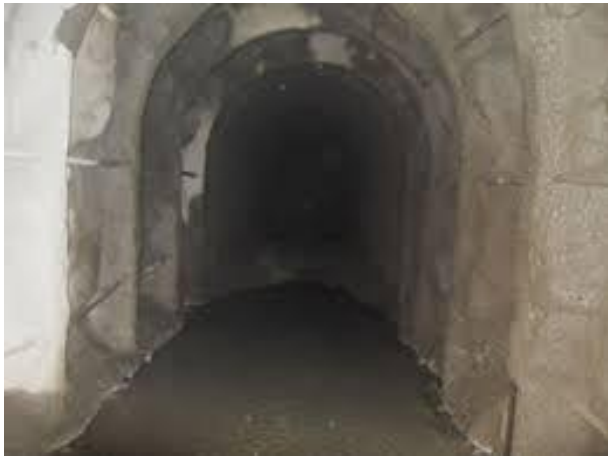
Figura 5. Sostenimiento por hormigón armado. Fuente: Subterráneo ( www.subterráneo.com.pe ).
