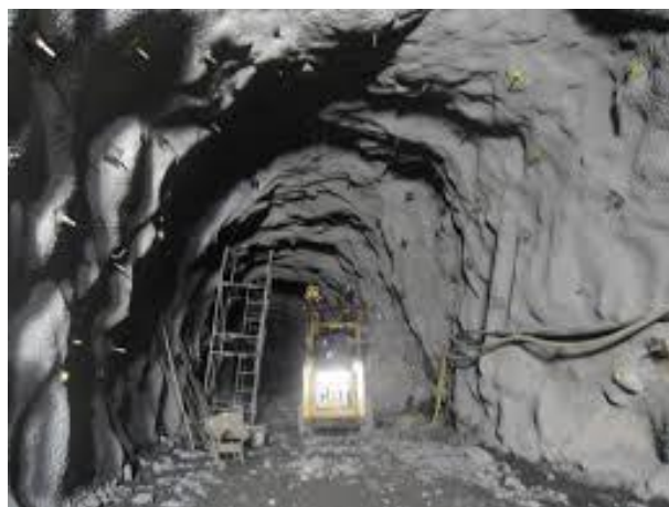
Figura 3. Sostenimiento por cemento lanzado con pernos de anclaje Fuente: besttodder toys.eu
