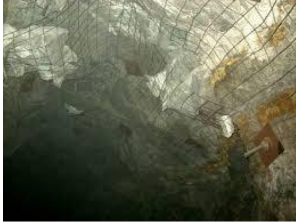
Figura 4. Sostenimiento por malla con pernos de anclaje. Fuente: YouTube ( www.youtube.com ).
