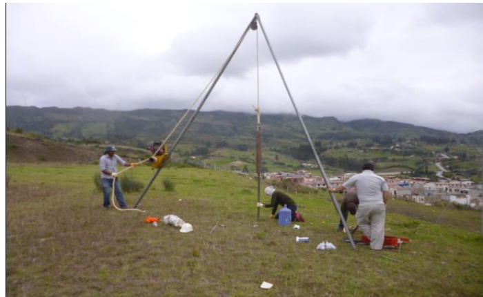
Fotografía 19. Ensayo de penetración estándar – SPT
