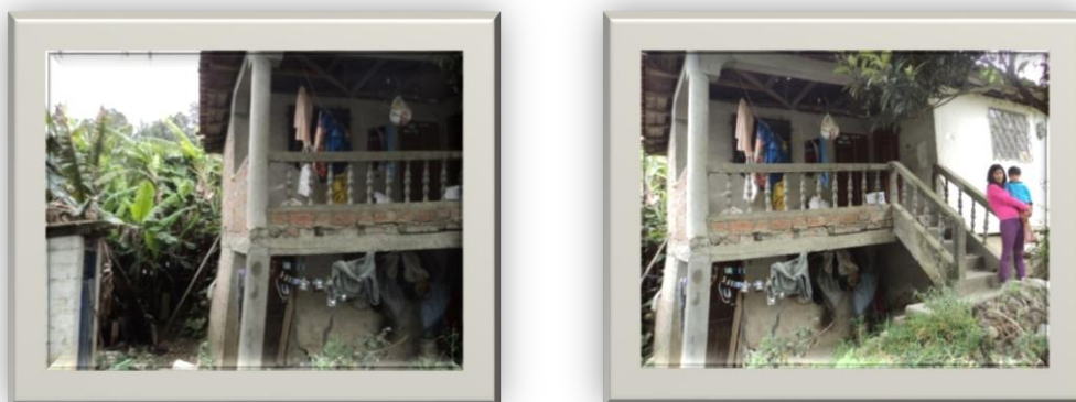
FOTO 35: VIVIENDA AFECTADA POR TRACCION DIAGONAL.
