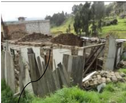
Foto Nro. 28.- Construcción de adobe con mampostería no reforzada.
