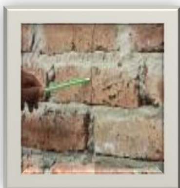
Foto Nro. 16.- Fisuras por retracción del mortero
