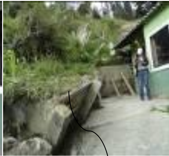
Foto Nro. 3.- Patología de la vivienda ocurrida por defectos en el diseño y construcción., vivienda vulnerable a deslizamiento de talud.
