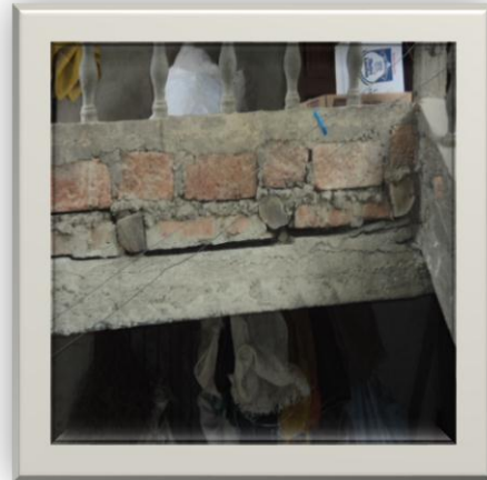
Foto 35.2.- Fisuras de 1 cm en la base de la columna superior y abertura de la base de mampostería de ladrillo en 3 cm y la losa de hormigón armado como consecuencia de la flexión que genera la tracción diagonal.
