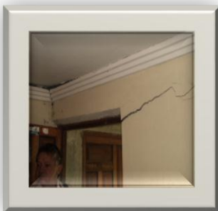
Foto 35.3.- Desplazamiento en 3 cm de la cimentación y mampostería de ladrillo de la fachada lateral; grietas verticales y horizontales de 3 cm como consecuencia de los cortantes producidos por el efecto del desplazamiento del apoyo de la columna exterior, desplazamiento que supera el límite elástico de algunos elementos estructurales
