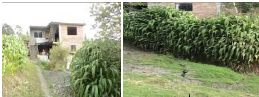
Foto Nro. 7.- Vivienda afectada por deslizamiento de tierra
