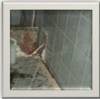
Foto: 32.4.- Despegue de la unión formada entre la mampostería y el piso por efecto del asentamiento diferencial (corte Local), determinada por la grieta de 10 cm que atraviesa el centro de la vivienda afectando la cerámica del piso.
