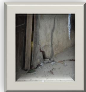
Foto 35.3.- Desplazamiento en 3 cm de la cimentación y mampostería de ladrillo de la fachada lateral; grietas verticales y horizontales de 3 cm como consecuencia de los cortantes producidos por el efecto del desplazamiento del apoyo de la columna exterior, desplazamiento que supera el límite elástico de algunos elementos estructurales
