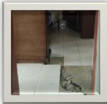
Foto: 32.4.- Despegue de la unión formada entre la mampostería y el piso por efecto del asentamiento diferencial (corte Local), determinada por la grieta de 10 cm que atraviesa el centro de la vivienda afectando la cerámica del piso.
