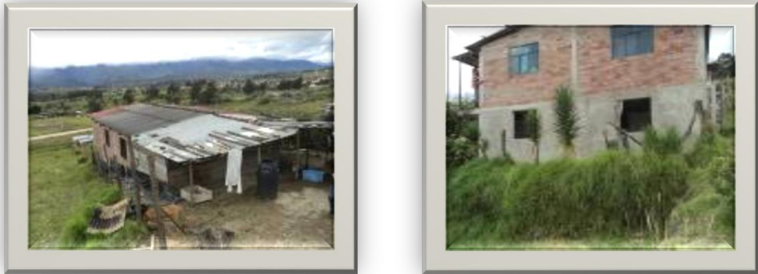
FOTO 34: VIVIENDA UNIFAMILIAR CON MAMPOSTERÍA DE LADRILLO NO CONFINADA.
