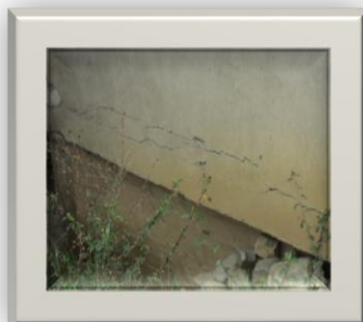
Foto 35.3.- Desplazamiento en 3 cm de la cimentación y mampostería de ladrillo de la fachada lateral; grietas verticales y horizontales de 3 cm como consecuencia de los cortantes producidos por el efecto del desplazamiento del apoyo de la columna exterior, desplazamiento que supera el límite elástico de algunos elementos estructurales
