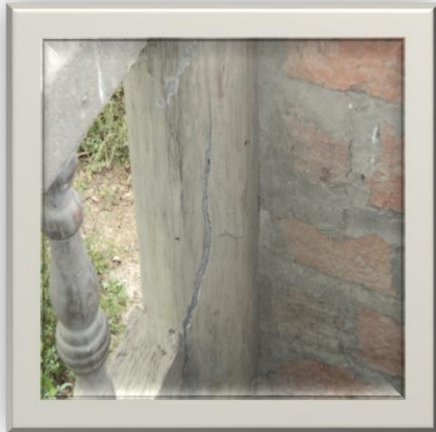
Foto 35.2.- Fisuras de 1 cm en la base de la columna superior y abertura de la base de mampostería de ladrillo en 3 cm y la losa de hormigón armado como consecuencia de la flexión que genera la tracción diagonal.
