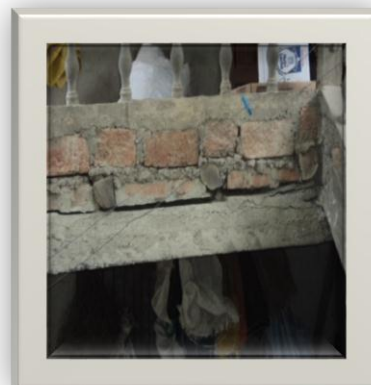
Foto Nro. 16.- Fisuras por retracción del mortero
