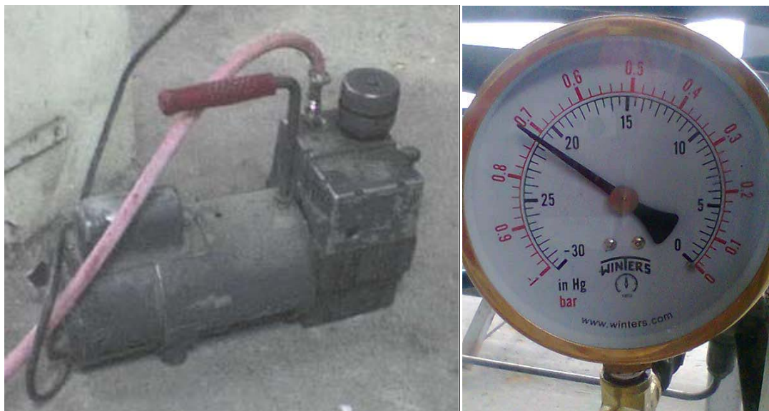
Imagen 9. Extracción del aire de las cañerías mediante bomba de vacío.
