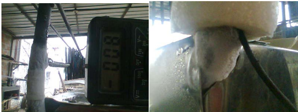
Imagen 7. Efecto de evaporación a la salida del condensador por falta de un intercambiador de gases.
