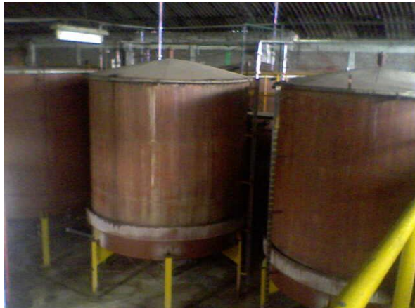
Fig. 2. Cubas de fermentación de la planta de alcohol.
