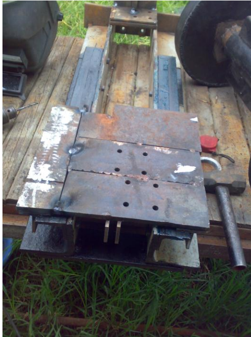
Fig. 5.11: Construcción de base vertical.
