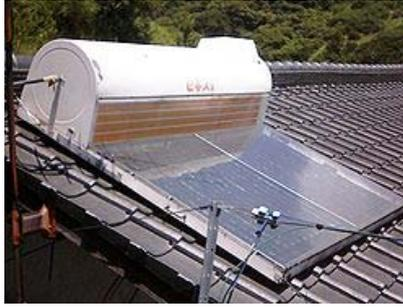
Fig. 2.3 Panel solar con tanque de almacenamiento
