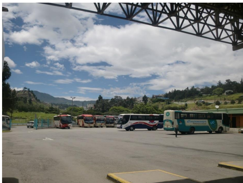
Foto # 35. Parqueadero de Buses
