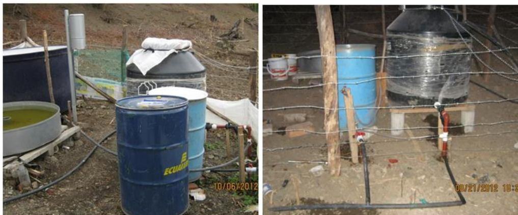
Figura 12. Instalación del cabezal de riego y protección con cerca de alambre.
