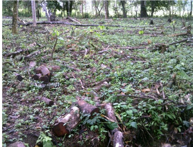
B. Adecuación del terreno para el establecimiento del ensayo
