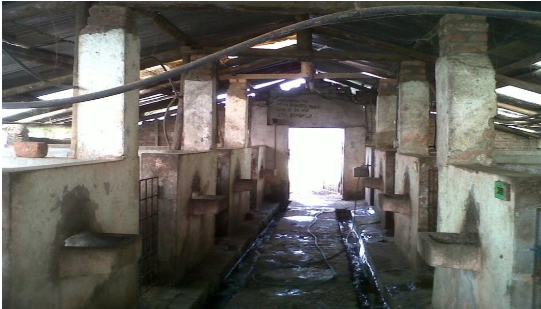
Foto 11. Chanchera parte interna
