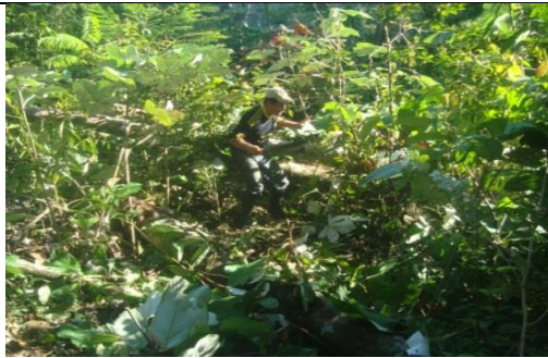
Foto 1. Limpieza del terreno.
