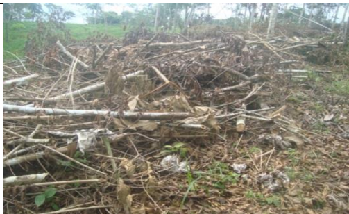
Foto 3. Despalizada del terreno
