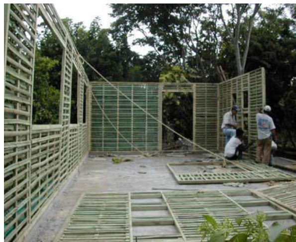
Figura 139. Piso colado antes de colocar los paneles
