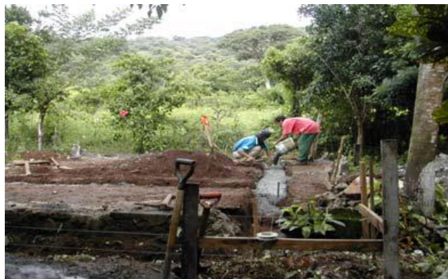
Figura 134. Excavaciones en el terreno
