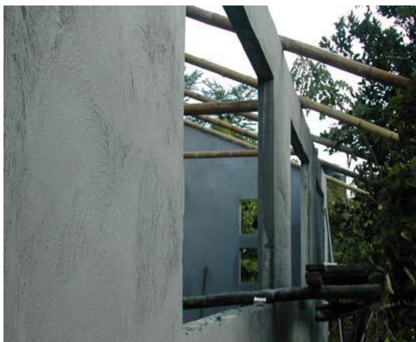
Figura 170. Aplanado de revoco para la afinación de las paredes
