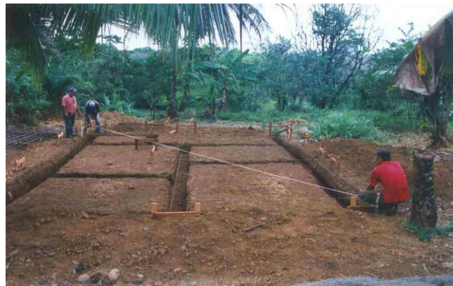
Figura 130. Excavaciones de zanjas en el terreno
