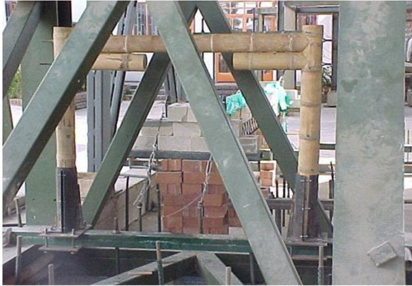
Figura 70. Montaje del marco.
