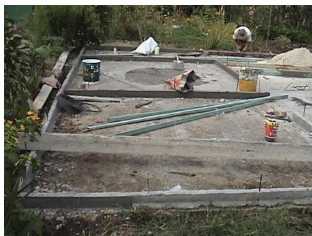
Figura 136. Proceso de construcción del cimiento
