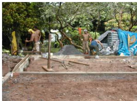
Figura 135. Fundición de muros
