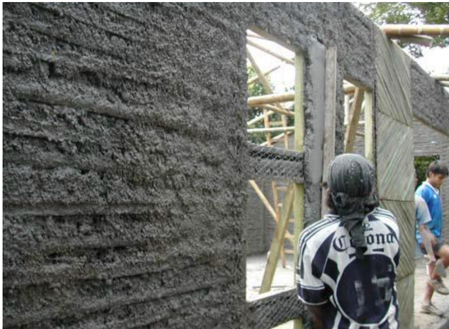
Figura 168. Zarpeado de paneles utilizando arena y cemento
