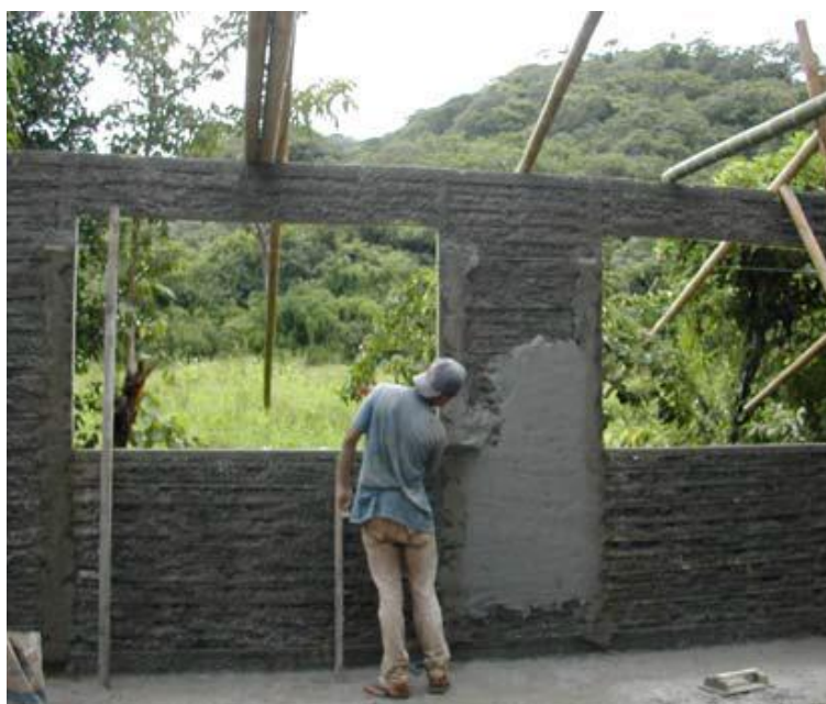
Figura 169. Revocado de paneles
