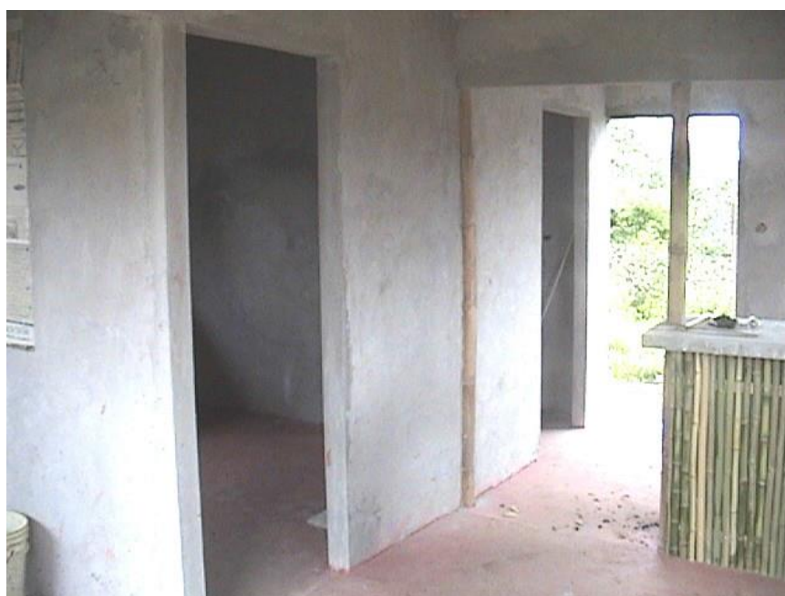
Figura 171. Paredes interiores revocadas
