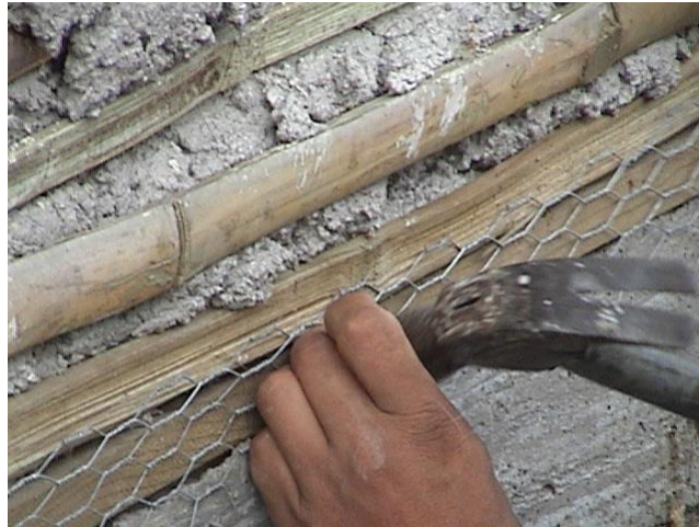
Figura 167. Ubicación de la malla sobre las paredes
