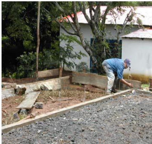
Figura 137. Nivelación con capa de material de cantera para colar el piso
