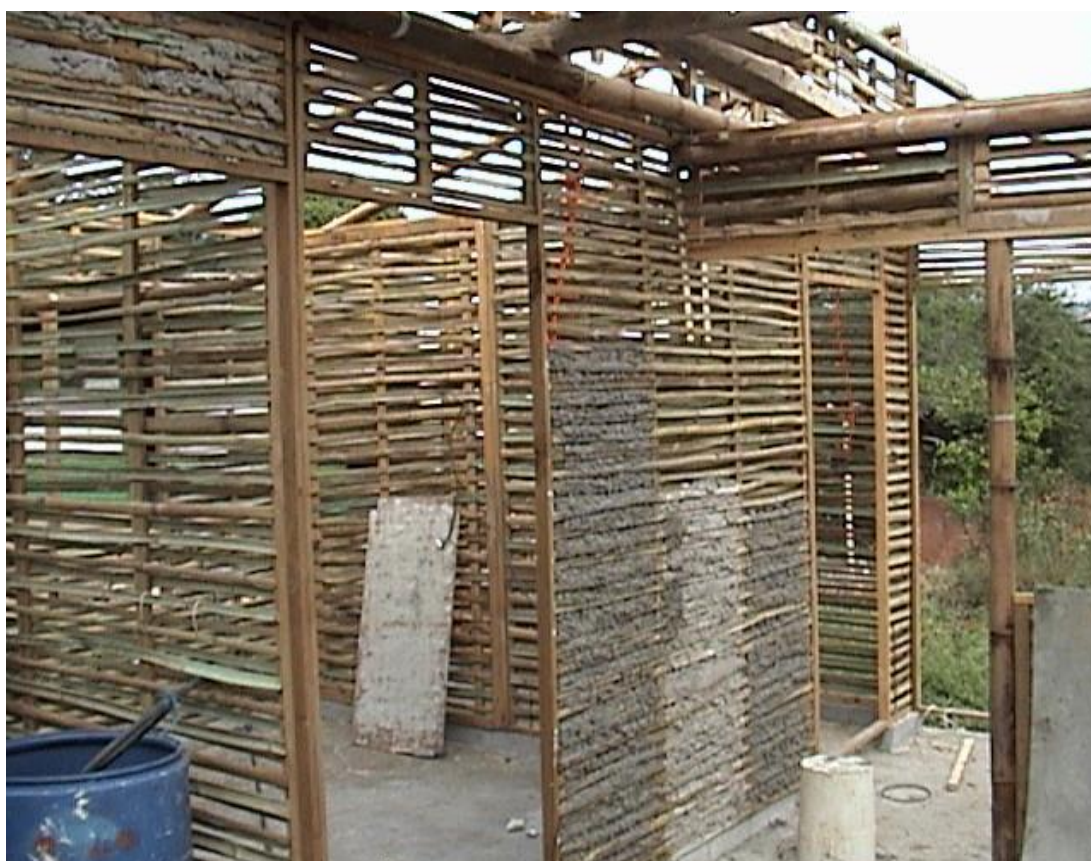
Figura 165. Inicio de llenado de panel
