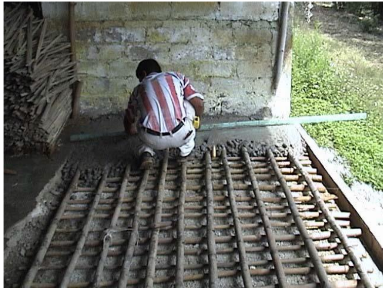
Figura 138. Fundición del piso
